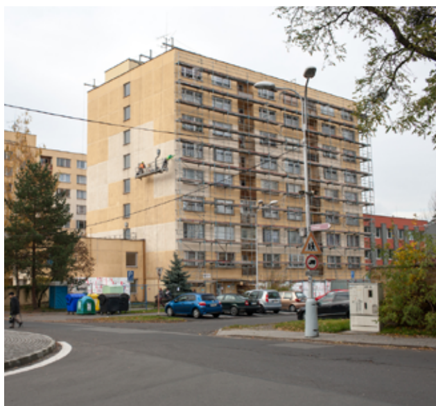
zateplování bytových domů v ulici Sadová, Frýdek-Místek projekt: CZ.06.2.11/0.0/0.0/15_018/0001201 - Úspory energie v bytových domech - ul. Sadová č. p. 604, 605 a 606
