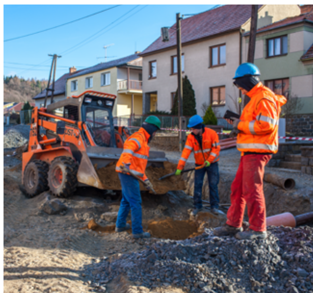
rekonstrukce silnice v obci Březina projekt: CZ.06.1.42/0.0/0.0/15_002/0000009 - II/373, III/37367 Březina průtah
